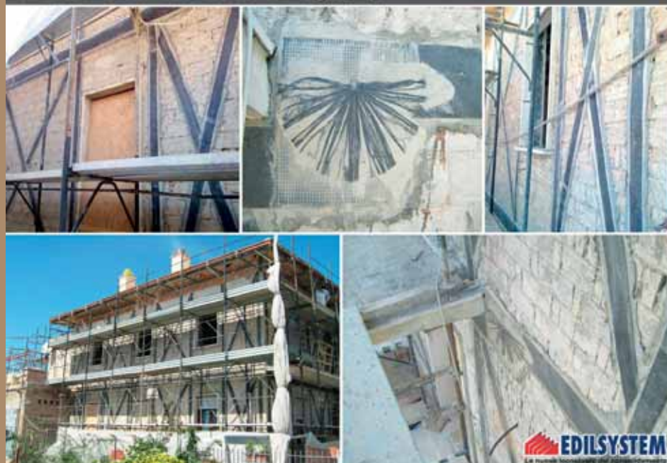
Edificio Civile Abitazione - Loc. Scafali Foligno (PG)
