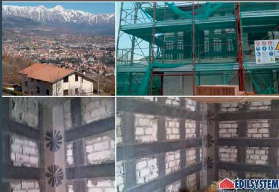
Edificio privato - loc. Roio (Aq)
