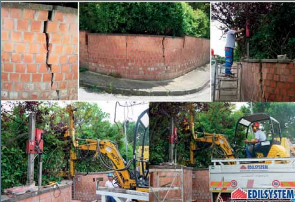
Edificio privato - Bientina (Pi)
