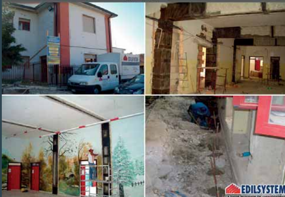
Scuola elementare - Castelluccio Valmaggioro (Fg)
