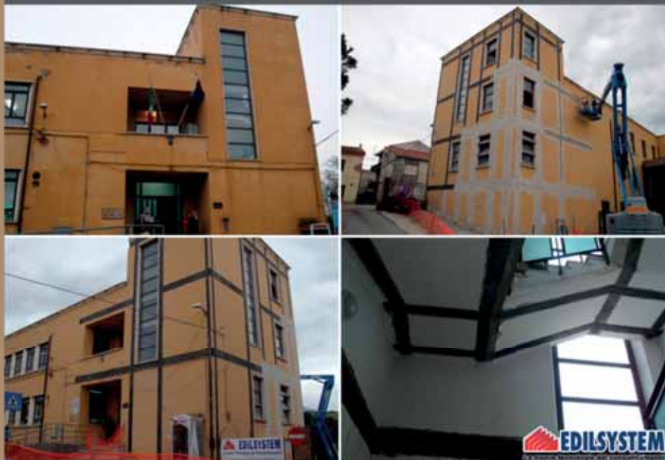
Comune di Campli (Te) - Scuola Castelnuovo
