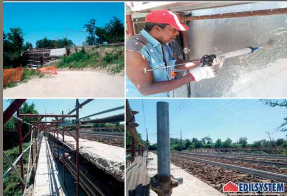
Ponte Ferroviario - Roma
