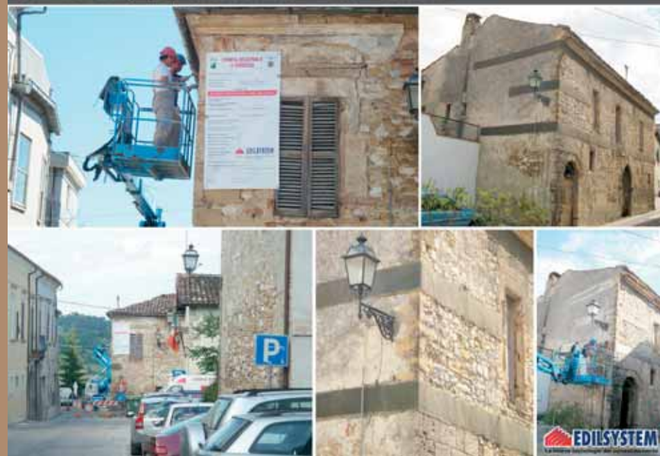
Comune di Campli (Te) - Casa dei Lanaioi - Messa in Sicurezza
