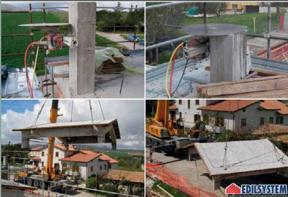
Edificio privato - loc. Bastardo (PG)
