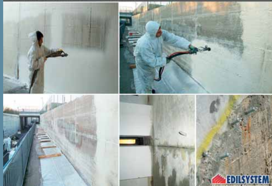
Sottopasso Ferroviario - San Martino dei Lupari (PD)
