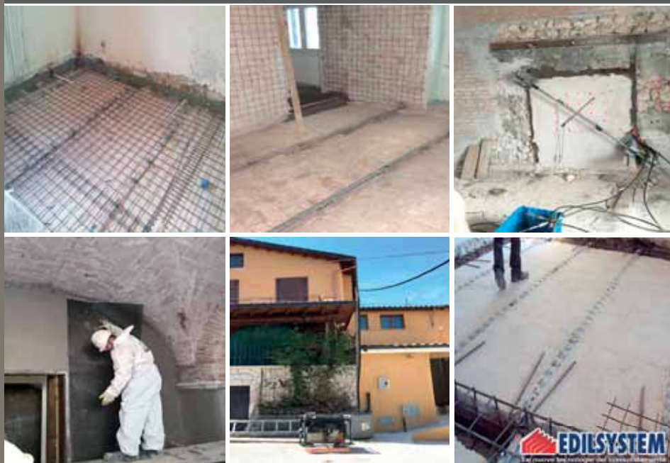
Edificio Privato - L'Aquila- (AQ)
