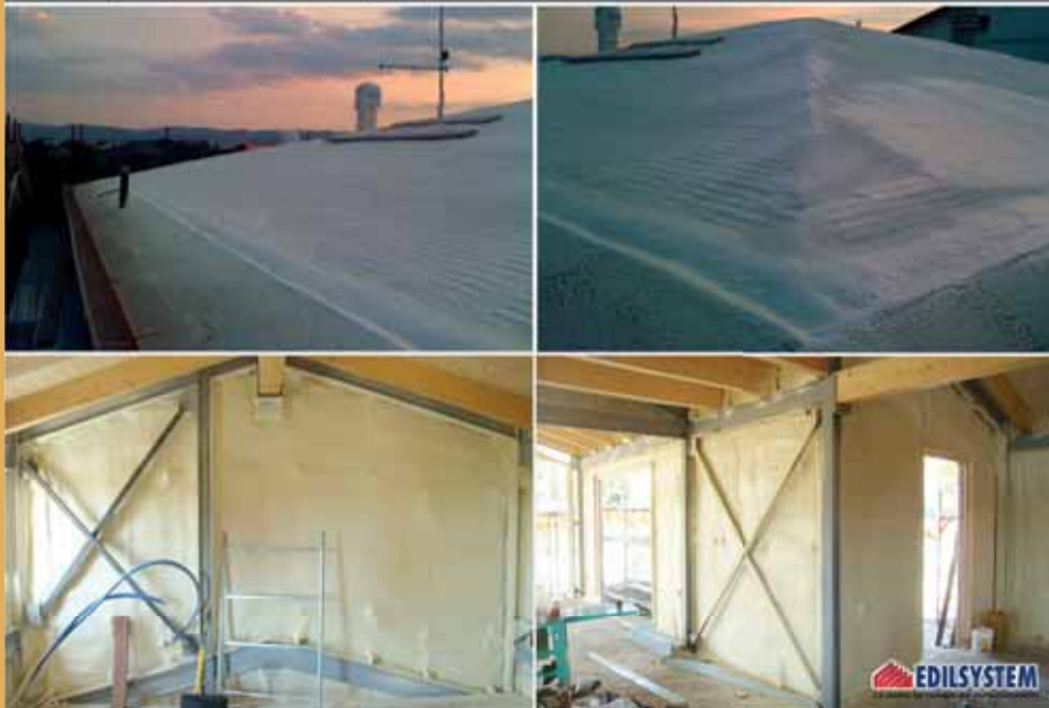
Edificio privato - Bastia Umbra (PG)
