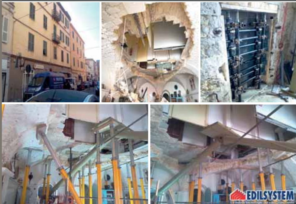
Edificio di Civile Abitazione - Sassari - (SS)
