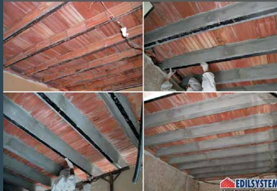
Edificio di civile abitazione - Roma (CIPOLLONI)
