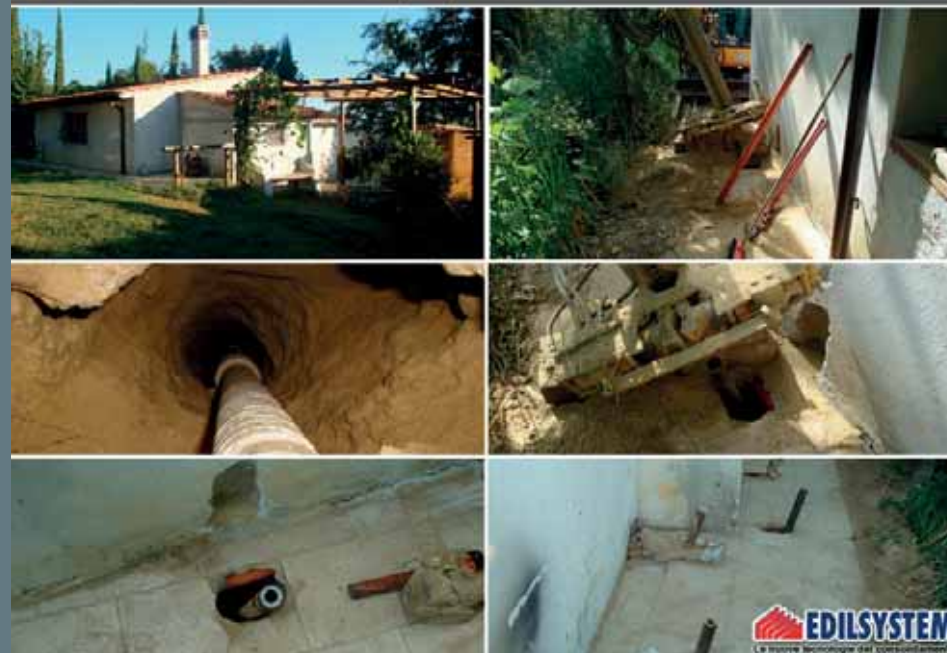
Edificio civile abitazione - San Oreste (Rm)
