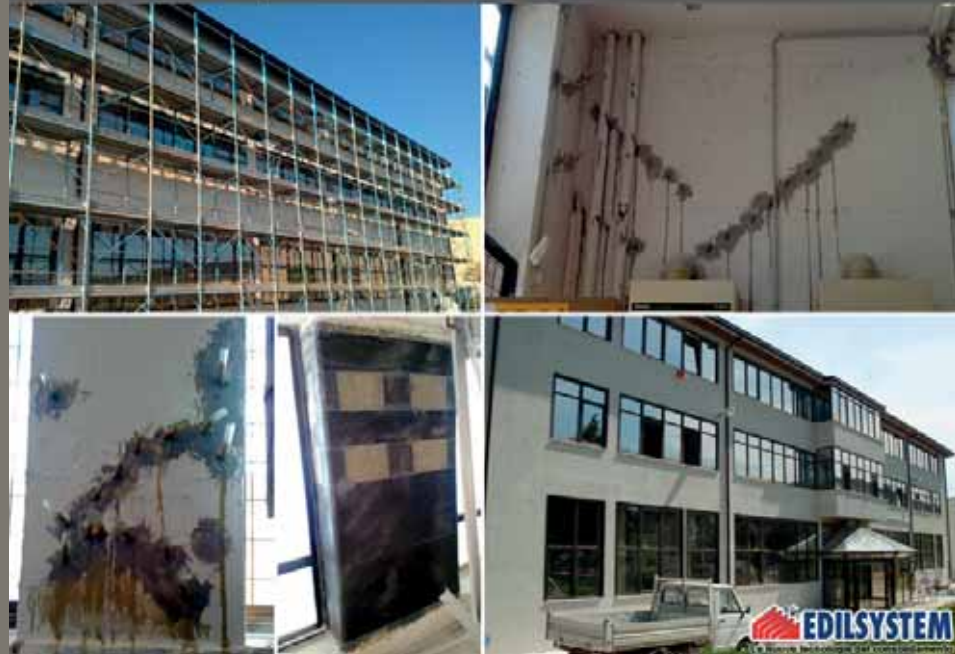
Edificio uso uffici - L'Aquila
