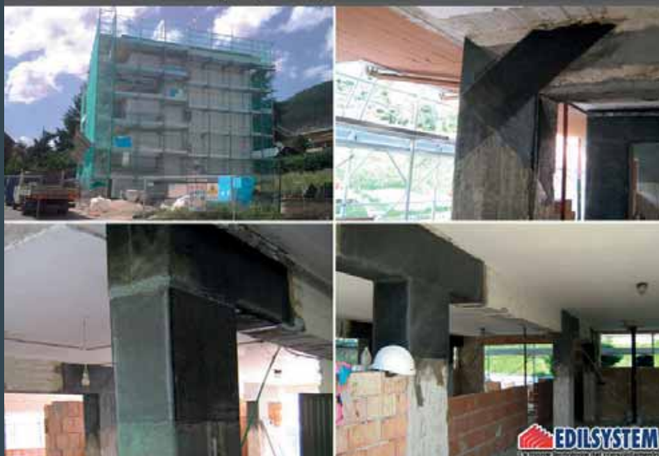
Edificio civile abitazione - L'Aquila (Cormas)
